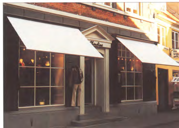
Til bredere vinduer bruges knækarmsmarkisen, der ligeledes opsættes efter princippet: ét vindue, én markise.
