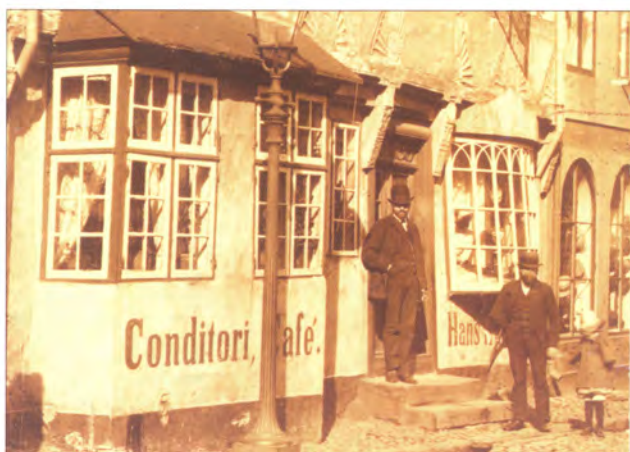
For ca. hundrede år siden var det ikke ualmindeligt at male skiltet direkte på facaden, her på et konditori i Stenbogade.
