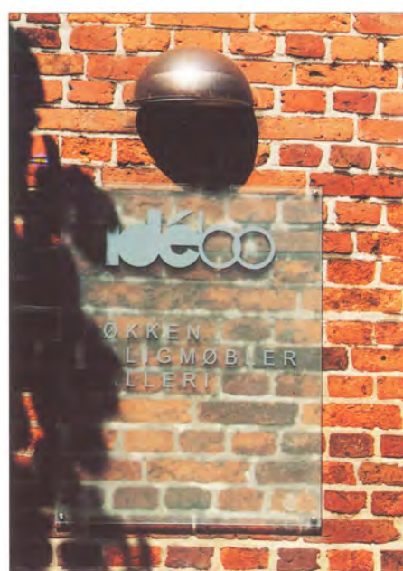
I særlige tilfælde kan der anvendes atypiske materialer, her et pladeskilt af acryl, som lader muren bagved være synlig.
